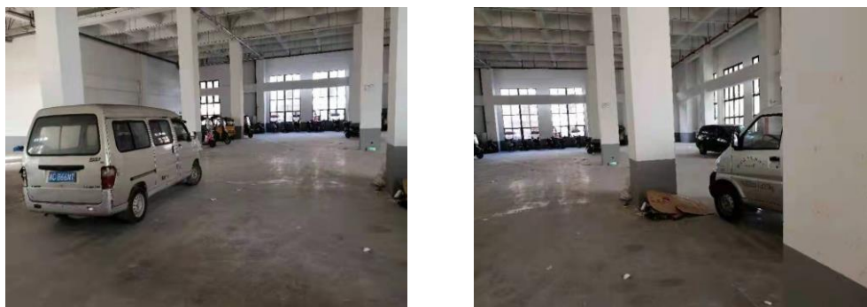
图 2-3 拟迁厂房现状情况图
